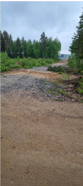
Kuva 20. Uutta tiealuetta. Kuvattu kohti Härjänruopantietä.
